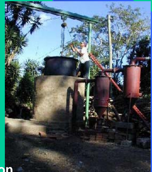
Pirolisis de la madera, Carbón (construcción de 2 Hornos CONTAINER)
